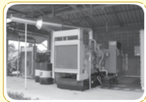
รูปที่ 1 เครื่องยนต์ผลิตกระแสไฟฟ้าที่ใช้จาก ก๊าซชีวภาพเป็นแหล่งพลังงาน
