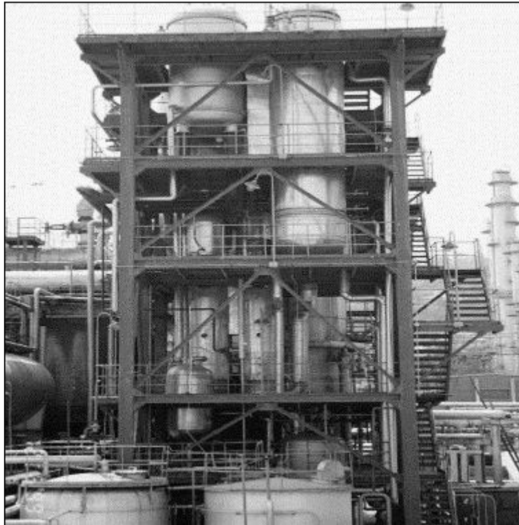
รูปที่ 1.12 การติดตั้งตัวแปลงความร้อนในโรงงานยางสังเคราะห์ของประเทศจีน
