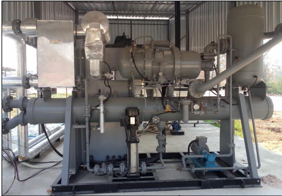
รูปที่ 4 ระบบผลิตกระแสไฟฟ้าแบบ ORC ด้านหลัง
