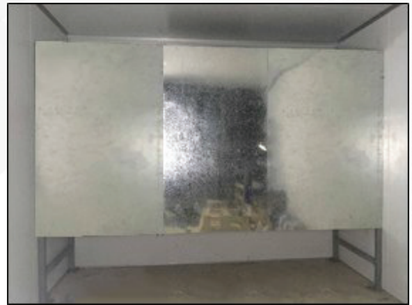
รูปที่ 1 ลักษณะของผนังแจกลมภายในห้องอบแห้งแบบรวมศูนย์จริง
