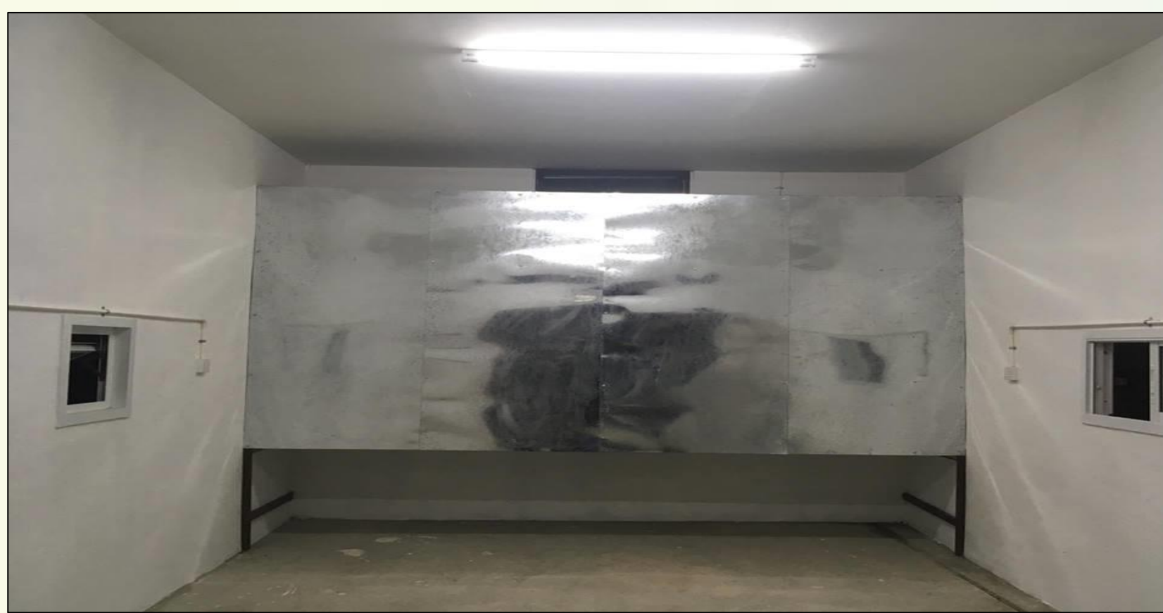
รูปที่ 6 ผนังแจกลมภายในห้องอบแห้งแบบรวมศูนย์ รูปที่ 6 เป็นรูปผนังแจกลมปิดด้วยแผ่นสังกะสีเรียบขนาดเท่ากับความกว้างของห้อง แต่ด้านบนและด้านหลังเป็นช่องให้อากาศสามารถหมุนเวียนได้
