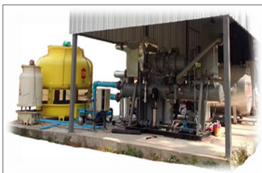
รูปที่ 6 วัฏจักรแรงคินสารอินทรีย์ขนาด 20 kW e
