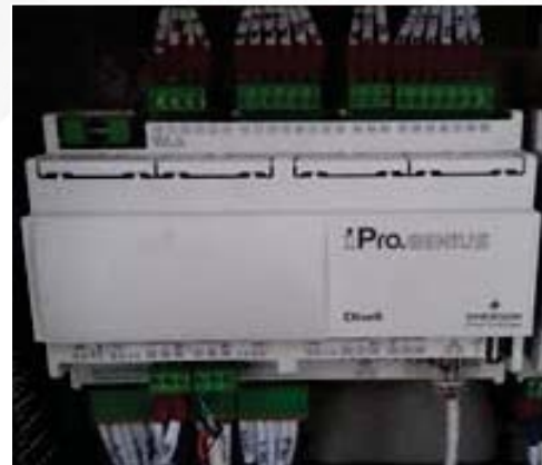
รูปที่ 8 ส่วนควบคุมหลักของวัฏจักรแรงคินสารอินทรีย์
